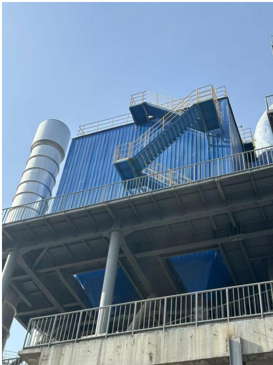
低压长袋式收尘器+30m 高排气筒
