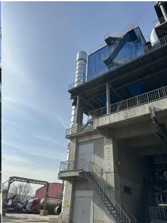
低压长袋式收尘器+30m 高排气筒
